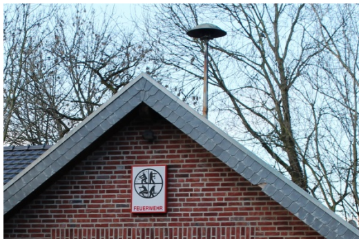
Abbildung 8: Sirene auf dem Feuerwehrgerätehaus in Hastenrath
