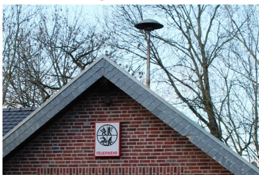
Abbildung 12: Sirene auf dem Feuerwehrgerätehaus in Hastenrath
