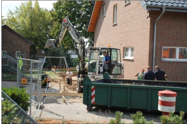
Abbildung 10: Erweiterungsbau in Stahe
