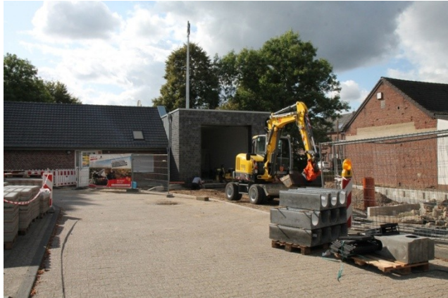
Abbildung 10: Erweiterungsbau in Hastenrath
