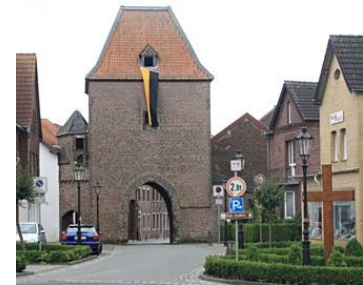
Abbildung 5: das Heinsberger Tor in Gangelter
